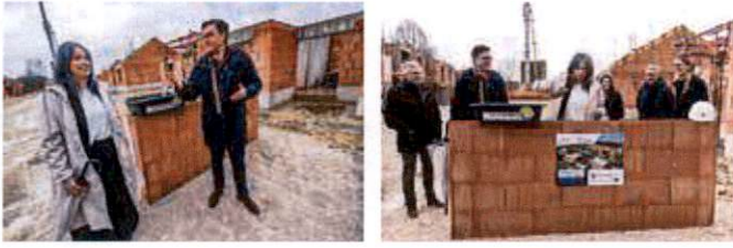
Pose de la 1ère pierre le 12 mars 2025
