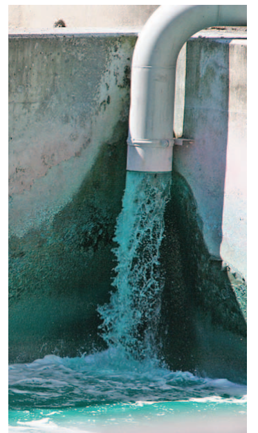
■ L'eau usée est acheminée dans de grandes cuves où elle sera traitée à l'oxygène puis par procédé de filtration.
